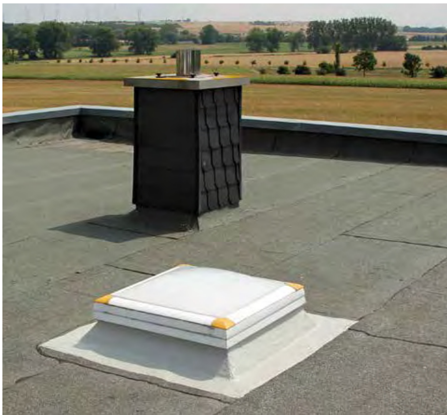
Abgedichtete Lichtkuppel aus PVC, ohne dass ein Voranstrich benötigt wird.
