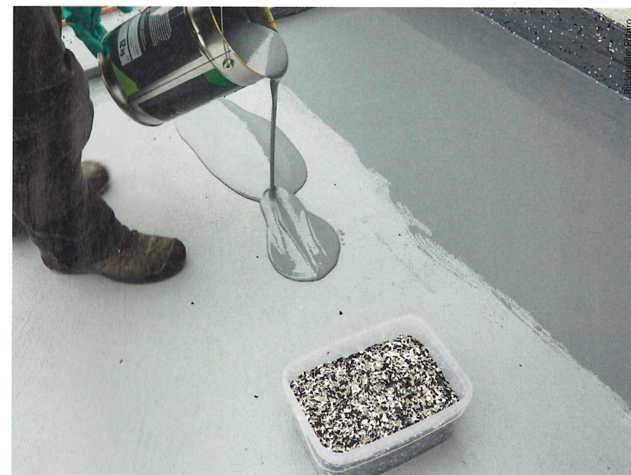
Die Chips dienen der Rutschfestigkeit und sind zur optischen Gestaltung in vielen Farben erhältlich.
