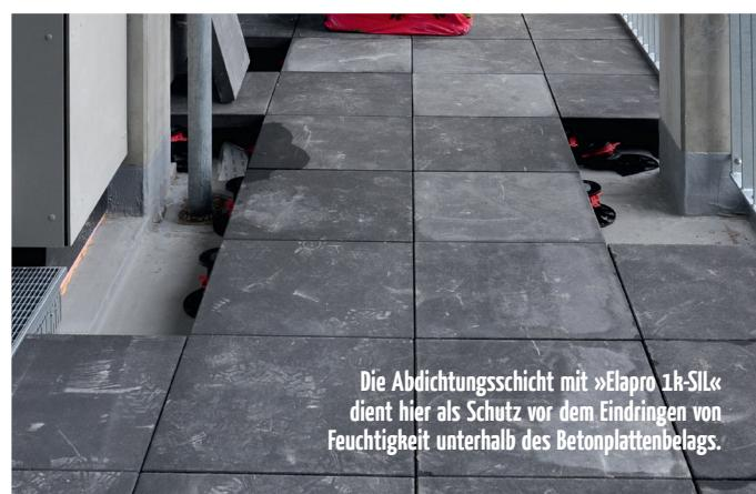
Die Abdichtungsschicht mit »Elapro 1k-SIL« dient hier als Schutz vor dem Eindringen von Feuchtigkeit unterhalb des Betonplattenbelags.
